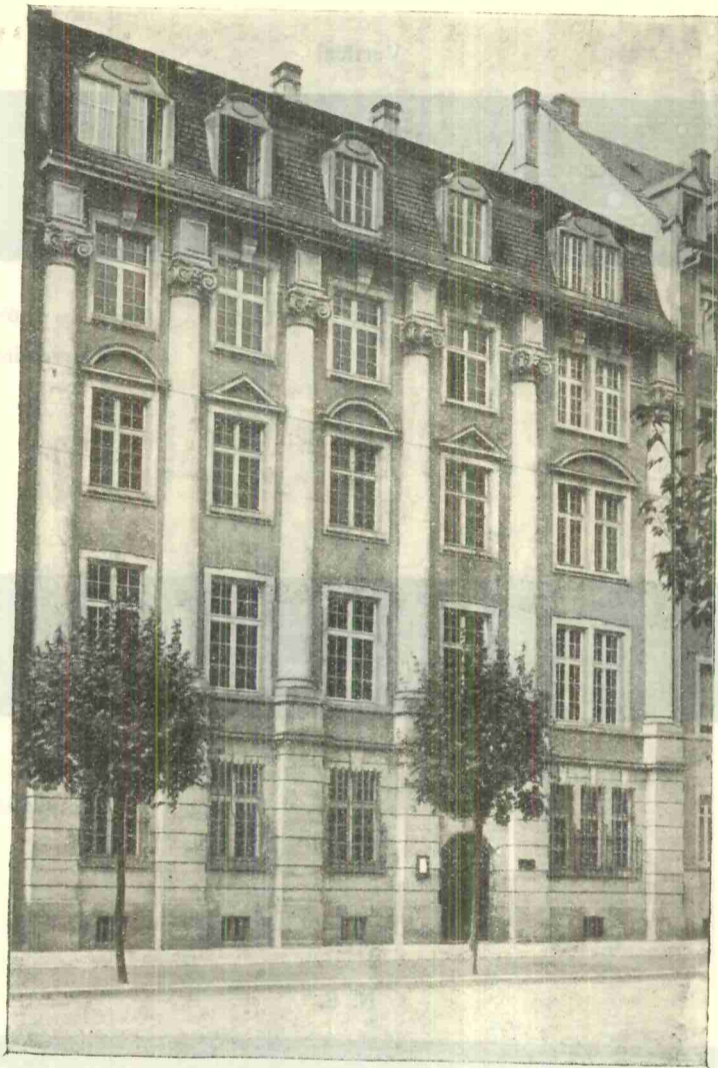
Façade de l'Institut de Physique du globe, 38, Boulevard d'Anvers à Strasbourg
